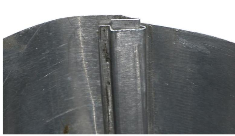
Terminación del ensamble Iso-Lock en liso
